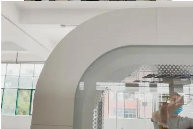
先安装两侧面弧形铝材，再安装中间碳塑板，请一定按照左右前后标签。
